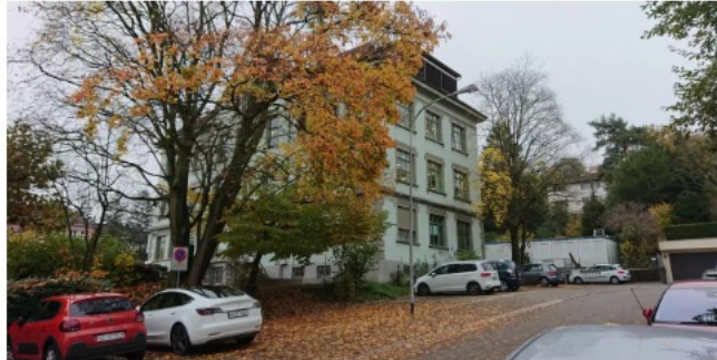
Schlieren - Schule Schulstrasse. - Kanton Zürich - Nau.ch
